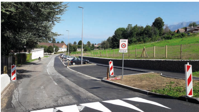
Travaux parkings aménagés
