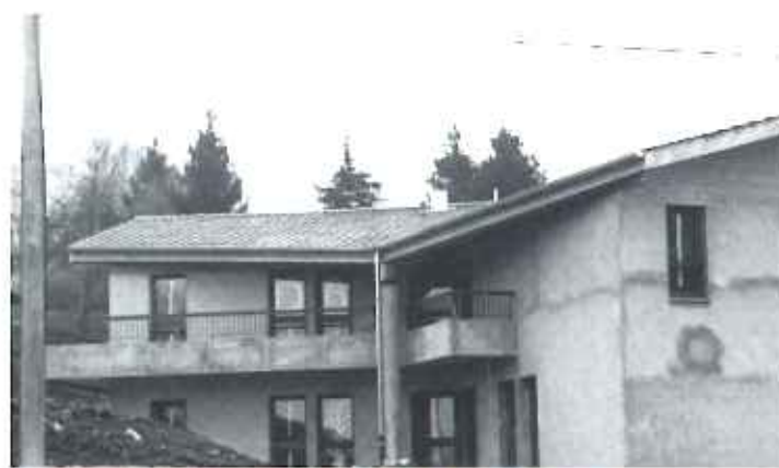
Travaux de construction de l'école élémentaire
