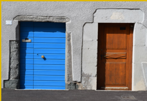
Portes à Tourronde, 1820, Lugrin © CCPEVA Les encadrements de porte ont été réalisés en pierre locale pour celle de gauche et probablement en pierre de Meillerie finement taillée pour celle de droite.
