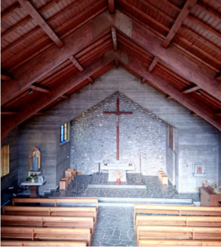
Église Saint-Maurice, par l'architecte Roger Buisson, 1963, Bonnevaux © CCPEVA
