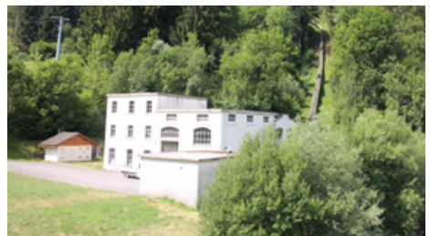
Usine hydroélectrique, construite en 1915, Bonnevaux © CCPEVA
