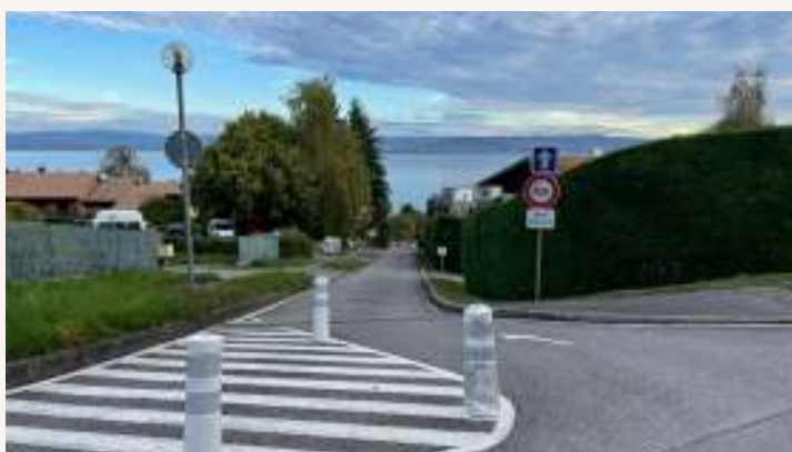
Sécurisation de voirie
